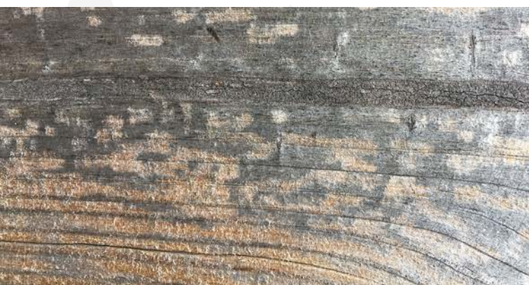
Fasádní obklad v průběhu procesu stárnutí (nepravidelné uvolňování – vymývání dřevního vlákna)
