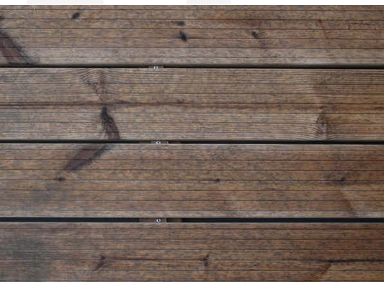
Terasové profily ve fázi začínajícího procesu šednutí. (přirozené jsou mapky připomínající vznikající plíseň)
