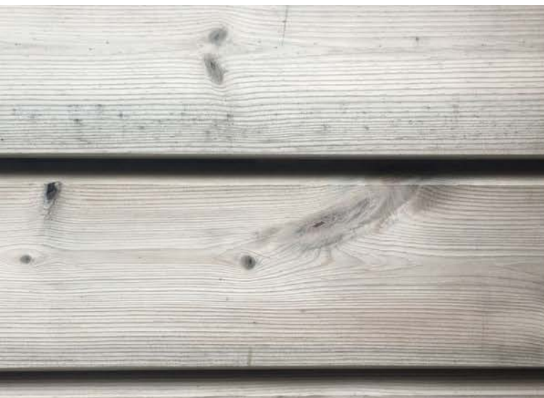
Detail na ideálně ventilovaný obklad (SSS) v průběhu procesu stárnutí severní strana - stáří 3 roky krásná světle še – lehké zvrásnění povrchu)
