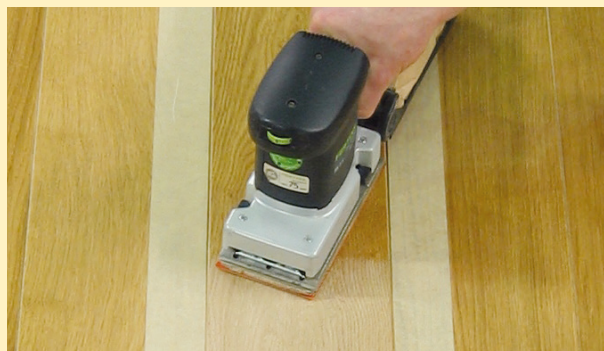
Rovnoměrné obroušení poškozeného povrchu
